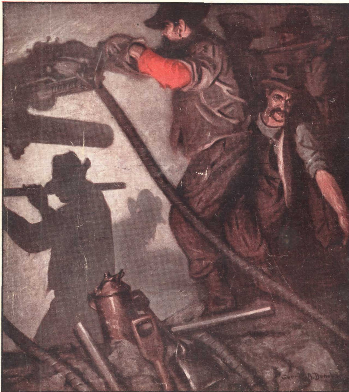
SCAVO DI UNA GALLERIA MEDIANTE PERFORATRICE AD ARIA COMPRESSA.
